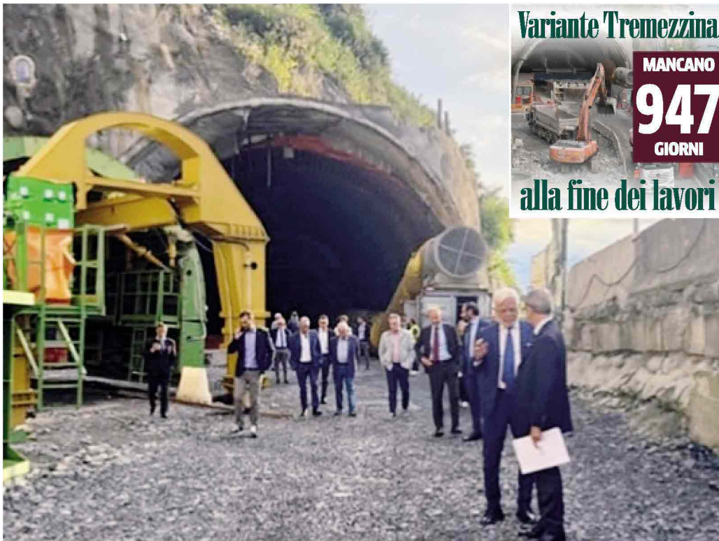
Il sopralluogo all'interno del cantiere di Colunno
